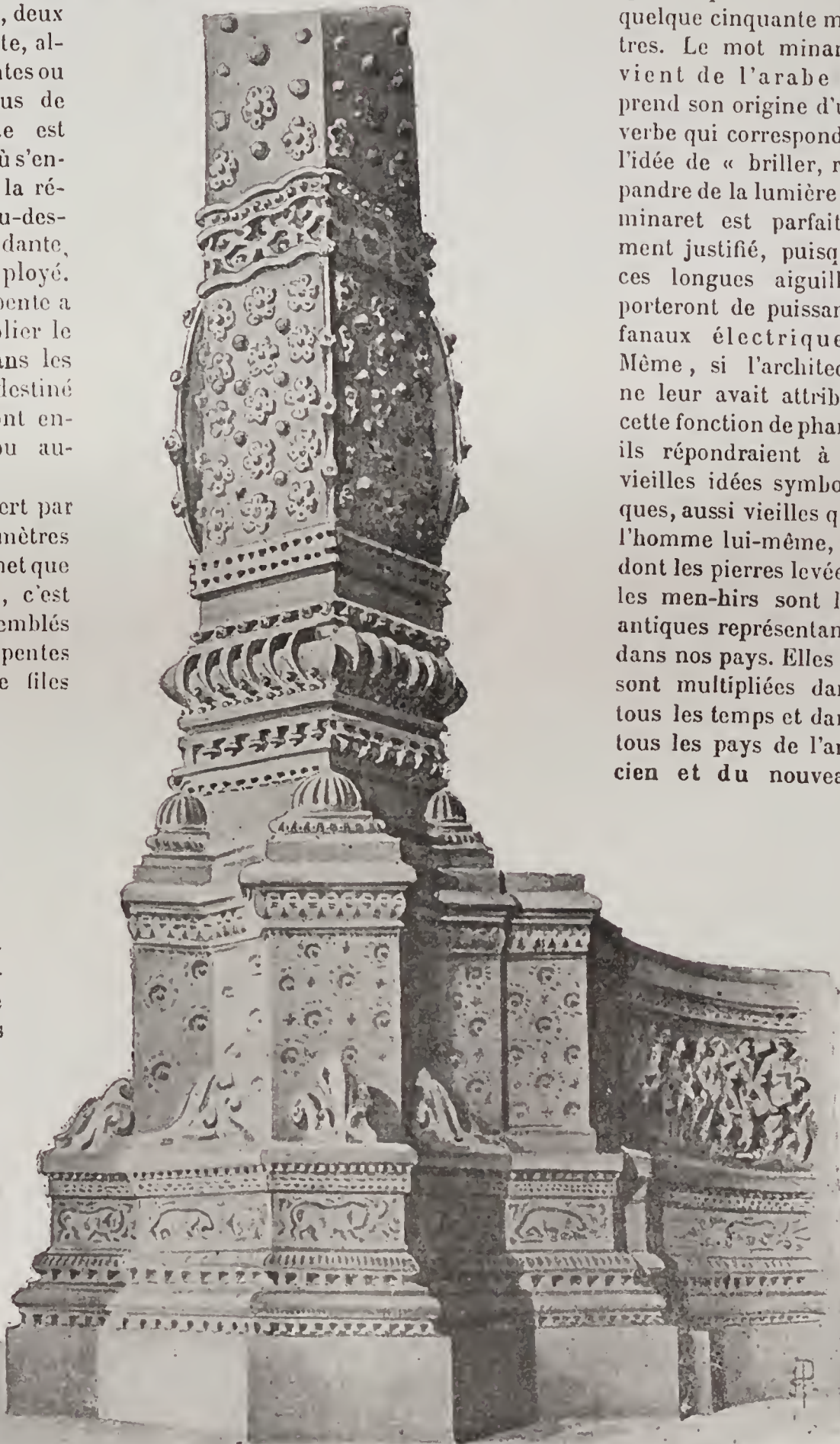
Soubassement et départ du minaret.
